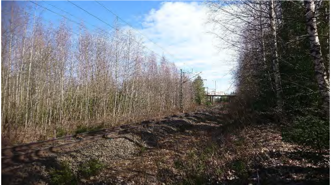
Kuva 11. Liito-oravan kulkua Savon radan yli voivat haitata junaradan ajojohtimet. Karilan metsän D pohjoispuolella radan varressa oleva puusto on hieman ajojohtoja korkeammalla.
