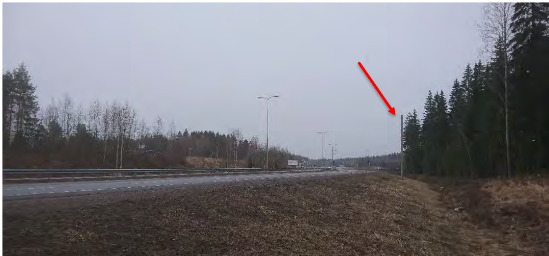
Kuva 10. Liito-oravan kulku Lahdentien yli on turvattu hyppytolpilla, mutta niiden toimivuus on epävarmaa. Nuolella on osoitettu hyppytolppa. Tiealueen leveys on noin 60 m. Oikealla kuvassa Karilan metsä C ja vasemmalla Pitkäjärven metsikkö A.
